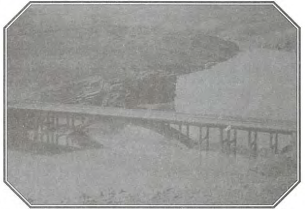
Ağın-Elazığ Karayolundaki Kohpinik Köprüsü (Ağın'a Yolculuk kitabından).
