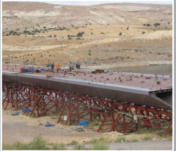
Köprü Çalışmalarının Son hali...
